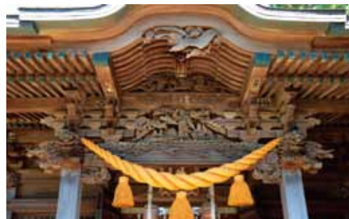
▲神社の破風（はふ＝正面に突き出たひさしの小さい屋根状の部分）の裏は造形が凝っていて見どころが多い。彫刻はもちろん、斗組（ますくみ＝柱と屋根の間のブロック状に組まれた部分）の精密さにも注目。（写真は第六天神社） ▲彫刻や斗組の設計図。設計士としての技術と芸術家の感性の両方が必要だった。
