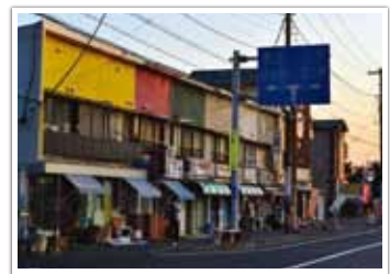
▲当初は8店舗×2棟を建設（写真上：宮崎さん提供）。右奥の1棟が当時の姿を残して現存している（写真下）
